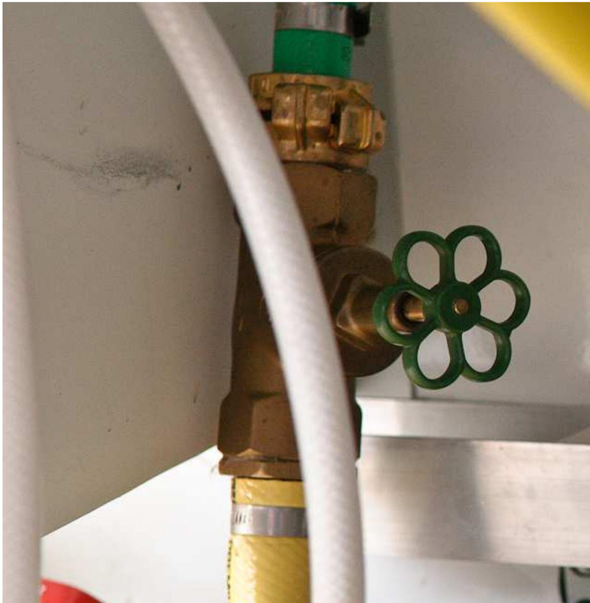
Abbildung 15 Wasserhahn für Frischwasserbetankung
