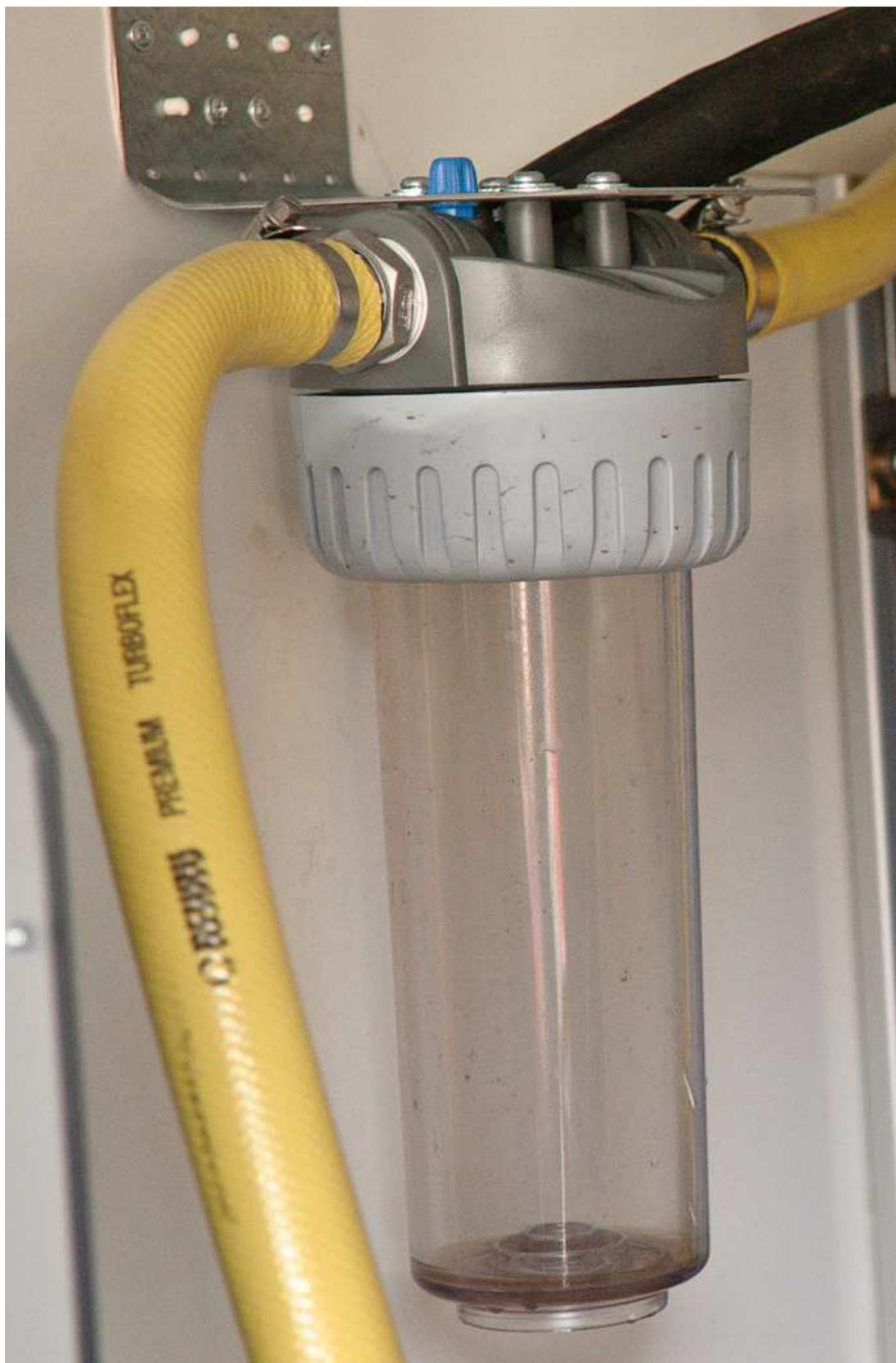
Abbildung 12 Frischwasserfilter 60 Micron
