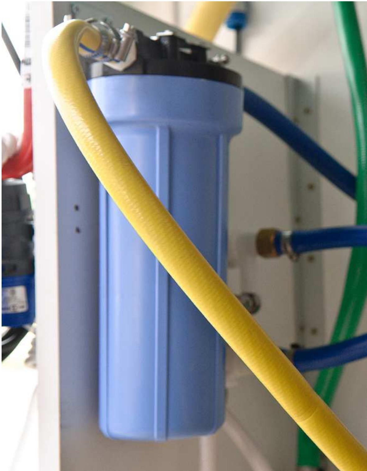
Abbildung 11 Frischwasserfilter Aktivkohle 5 Micron
