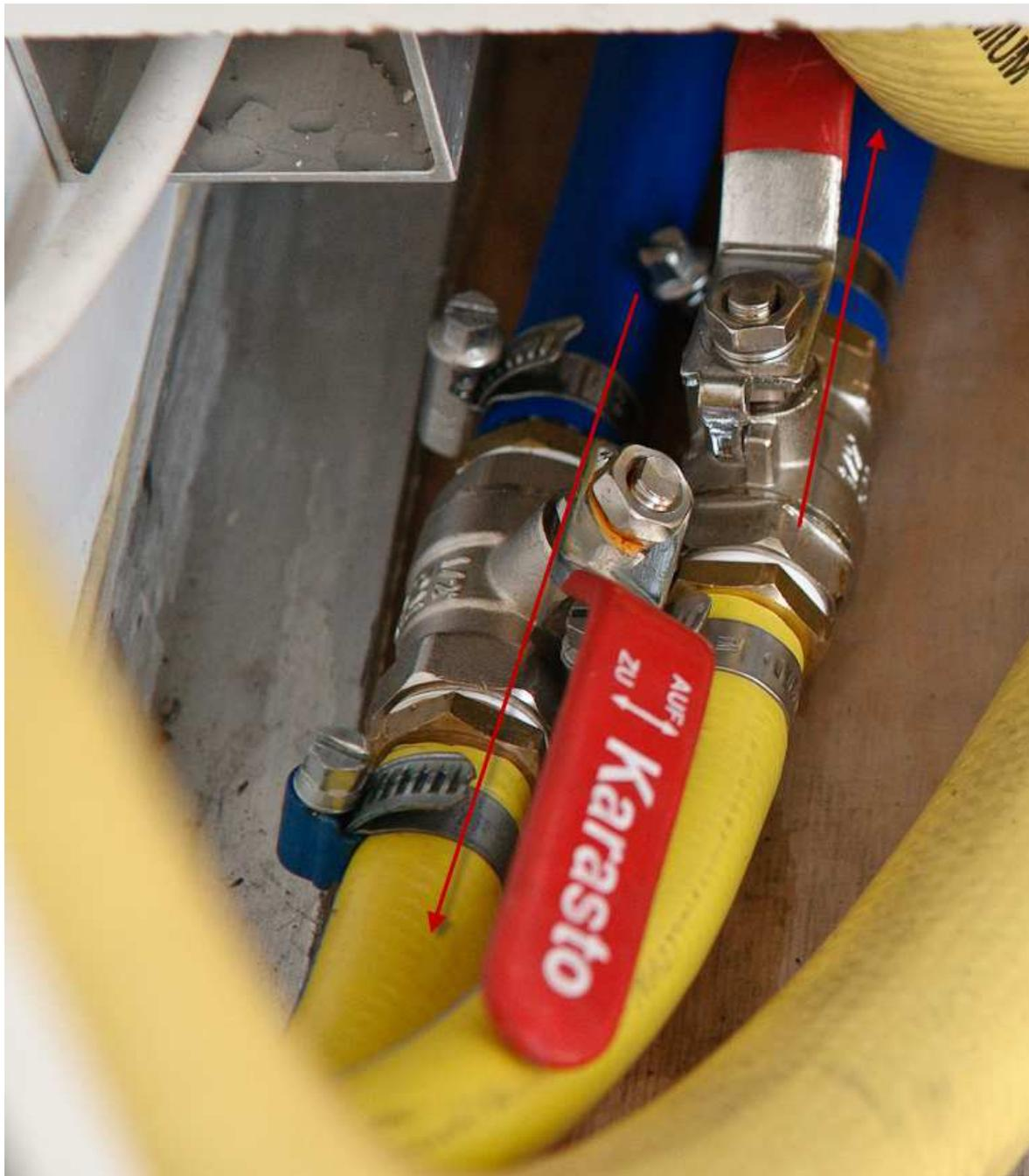
Abbildung 10 Kugelhahn für Frischwassertankentleerung
