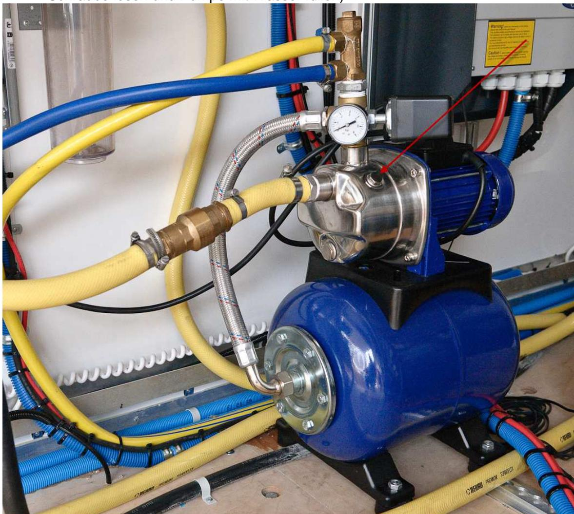
Abbildung 16 Hauswasserwerk
